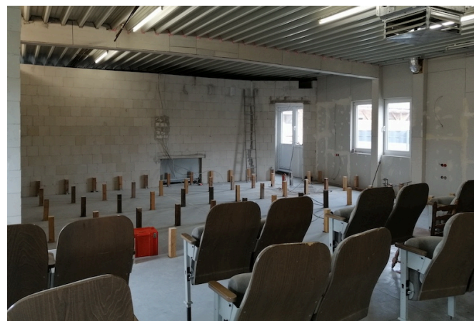
Blick vom zukünftigen Zuschauerraum auf die Theaterbühne
